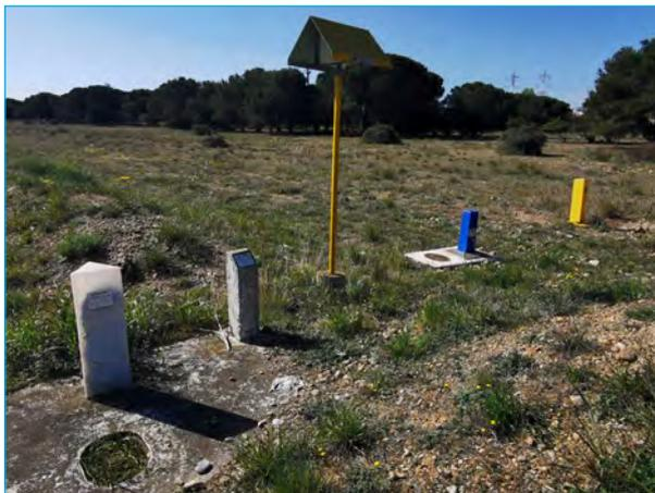
Bornes indiquant la présence de canalisations de transport de fluides et gaz
