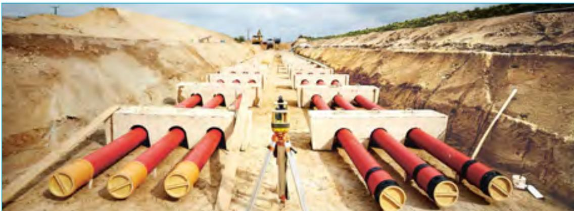
Chantier de création de 2 liaisons (6 câbles) souterraines à courant alternatif à 400 000 volts (Allemagne)
