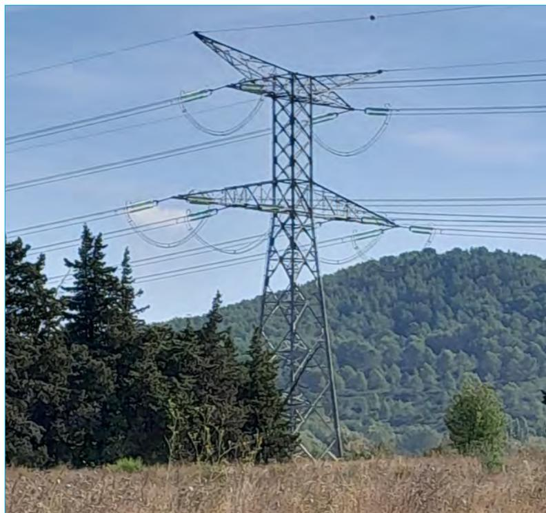
Exemple d'une ligne aérienne construite avec des pylônes de type F44
